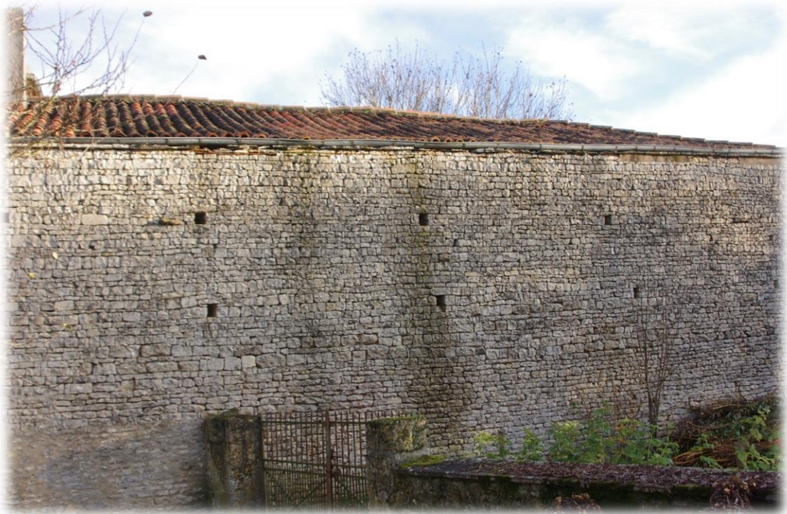
Figure 57 : Bâtisse en pierre sèche avec de nombreuses anfractuosités dans le mur et au niveau de la toiture, gîte potentiel pour les chiroptères – commune de Nanclars, photos prises sur site, ©NCA Environnement 2019.
